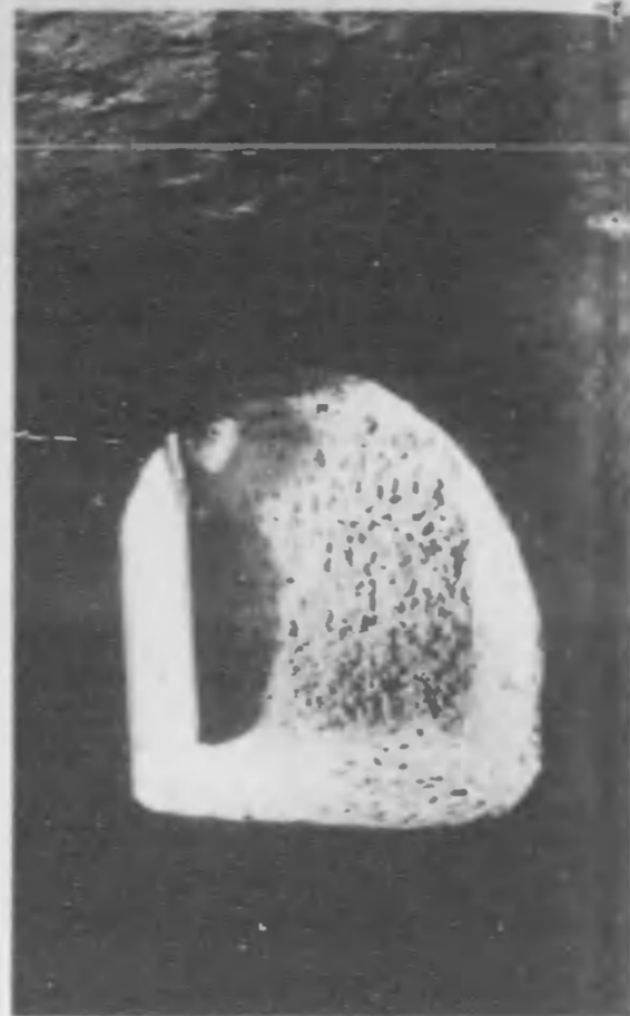
内部は寒期、馬蹄形に掘られてゐる。土質がよければ支保工はなくても大丈夫 空気が、空気がこれで自然に換氣される
