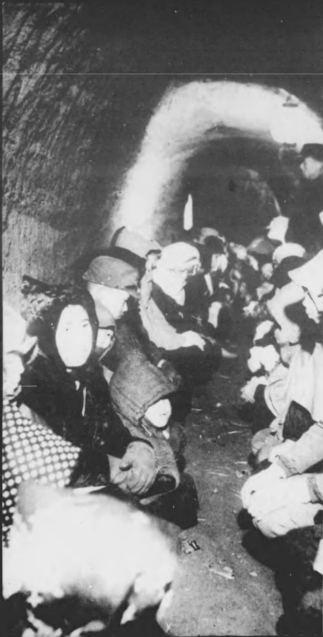
内部は寒期、馬蹄形に掘られてゐる。土質がよければ支保工はなくても大丈夫 空気が、空気がこれで自然に換氣される
