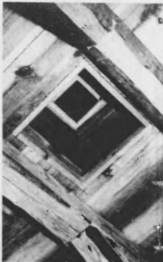
内部は寒期、馬蹄形に掘られてゐる。土質がよければ支保工はなくても大丈夫 空気が、空気がこれで自然に換氣される
