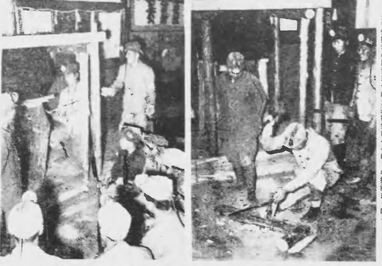
上 掘削の掘り方 左 吊岩の落し方 右 矢板の作り方 下 山候補者の服を着た選抜生は一心にその指導をうける
