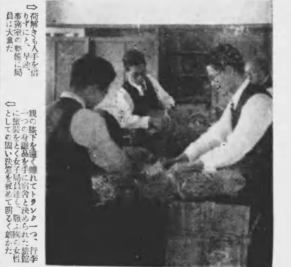
荷解きも人手を惜みず、早急で事務室の整理に局員は大奮闘中。背景には書類や箱が積み上げられており、活気ある作業の様子が伺える。
