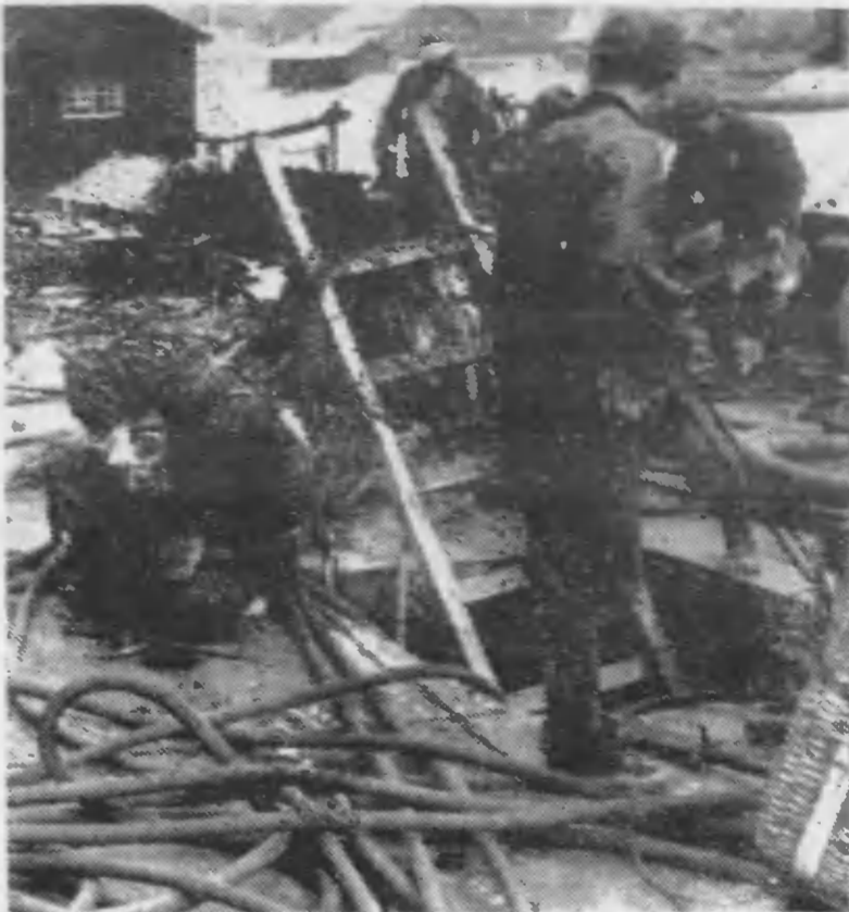
工員が奮闘、第三工区 で甲板の取付作業
