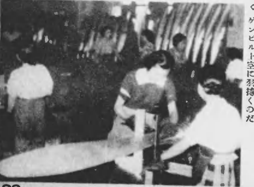
部品には精密度が必要だ。寸規器を使ってプロベラの規格検査。この一つ／＼がブリッヂに空に羽撃くのだ
