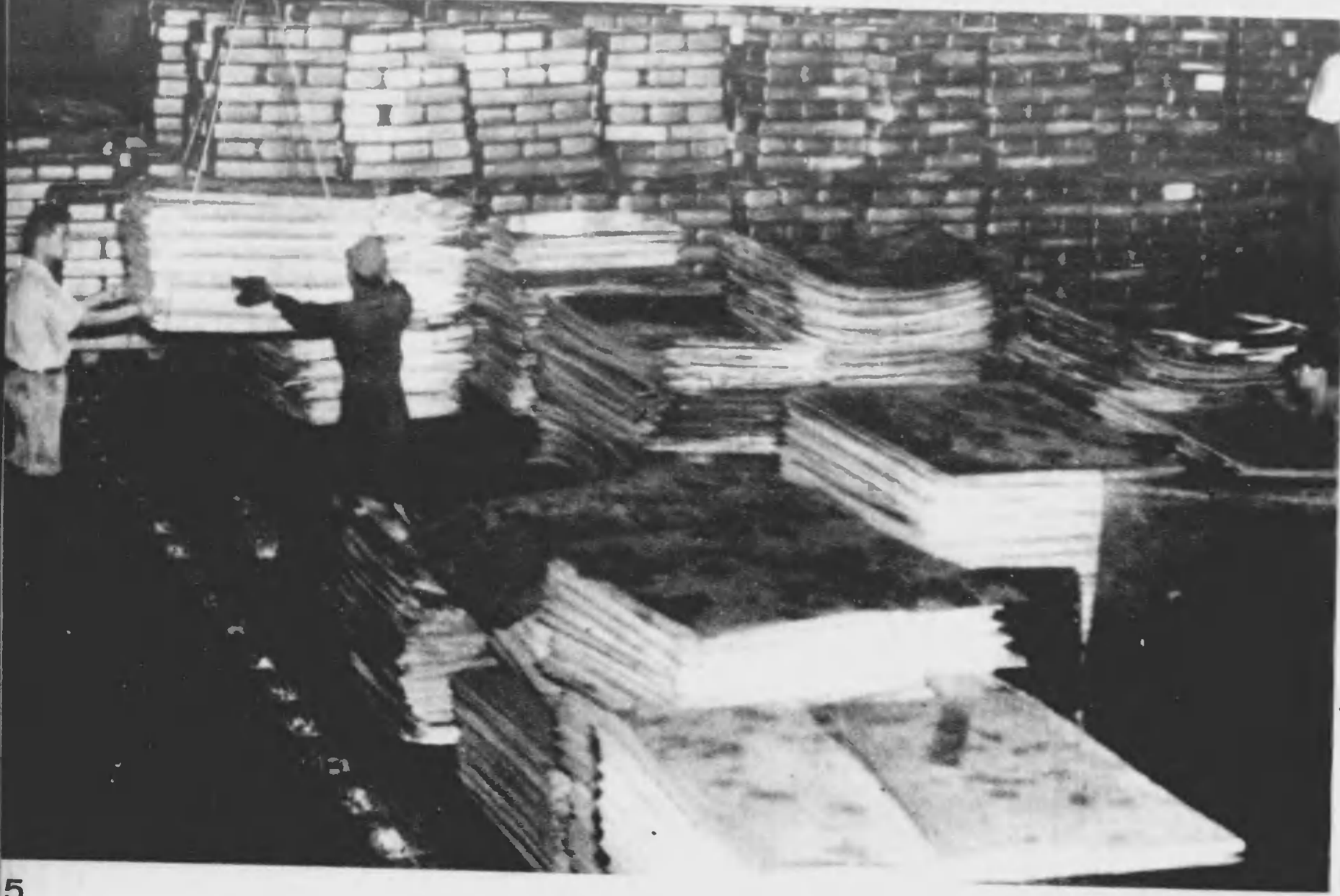
度の一枚一てれらけかに機延機はンミルラヂの状瓦煉 度百五氏攝みとし熔をンガンマとムウシネグマと鋼にムウ=ミルア純 るれら根もに體嗣もに翼にぐすがたこ るなと板いす る上米出がンミルラヂい強ひ行を便時れ人焼し入投に水らか位 るれか菜と山に開く橋は板延たれさ延紙のンミルラヂに形のままさま
