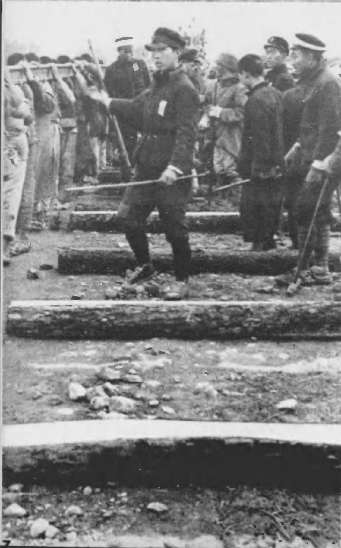
敵はレールの撤去は勿論、踏盤までも破壊してゐる。それをかたづけしから修復してゆく
