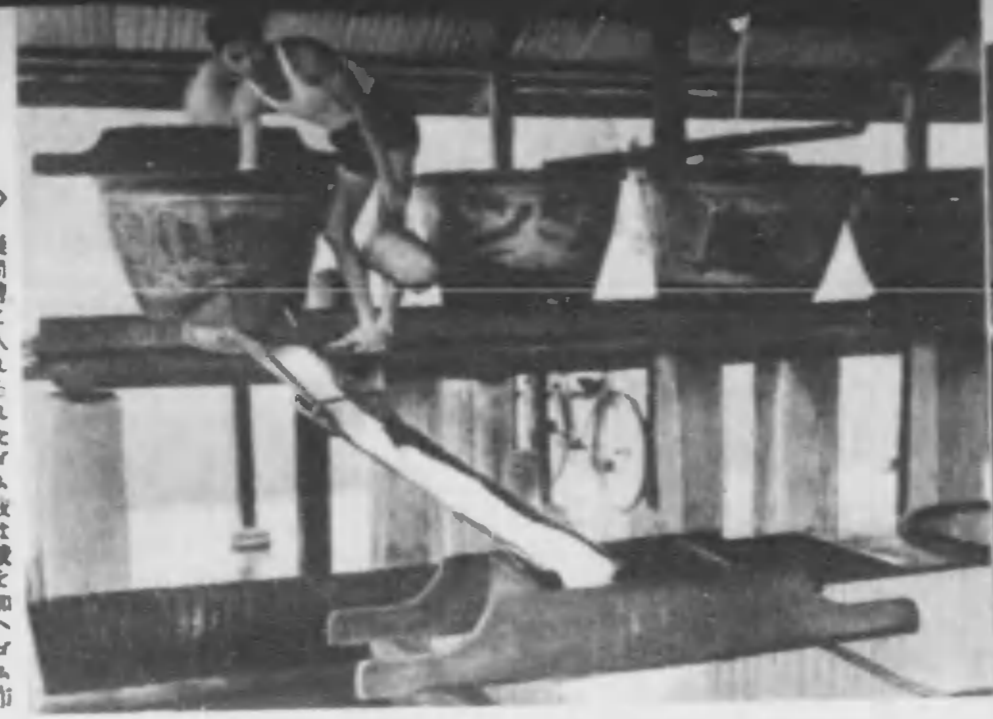
白いゴム布は煉製室でゴムの水を熱し造られて、美しいあめ色のゴムになる
