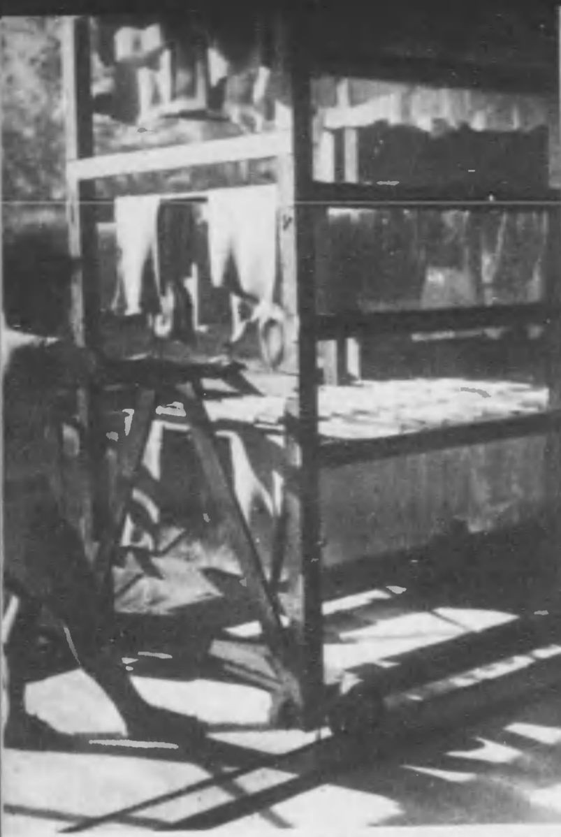
漉し桶に入れたゴム液は酸を加へゴム布が造られる
