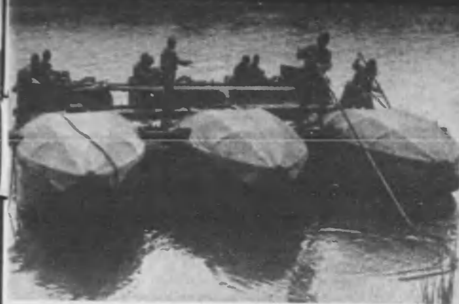
るれさ轉運てつよにエンジンモは橋門のこ 橋門たて立組てつよに舟疊折の度三
