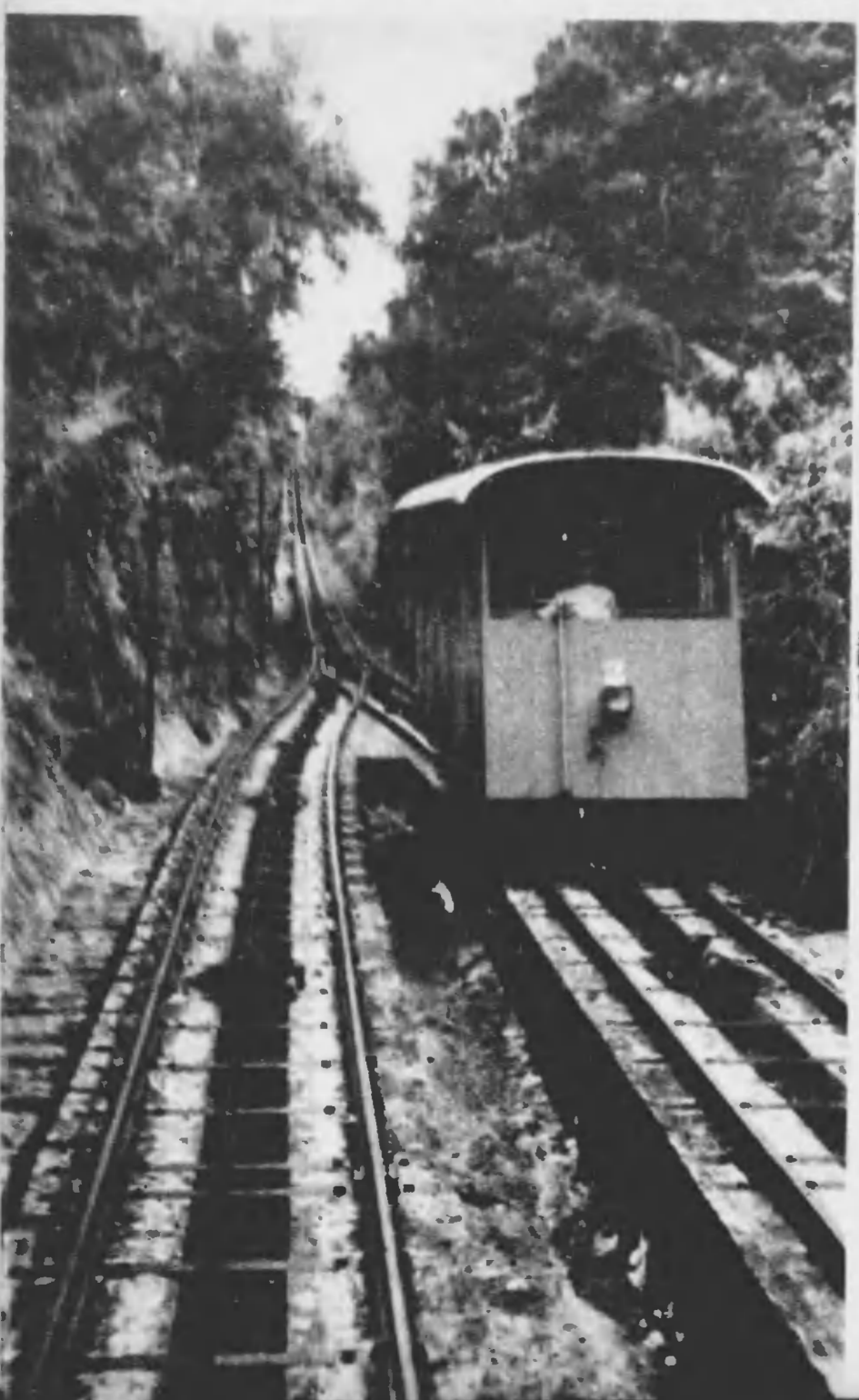
改裝されて錫石を運搬するかつての運搬用ケーブルカー
