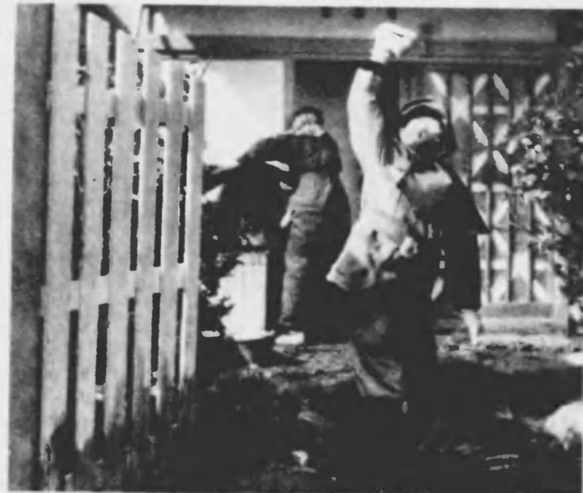
連絡係は隣組へ去を知らせ、確保は漏れをもつて現場へ
