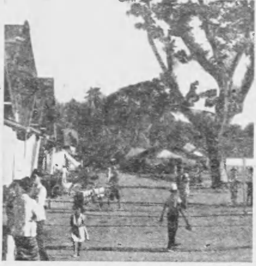
蘭領ボルネオ某地の石油採掘工事
