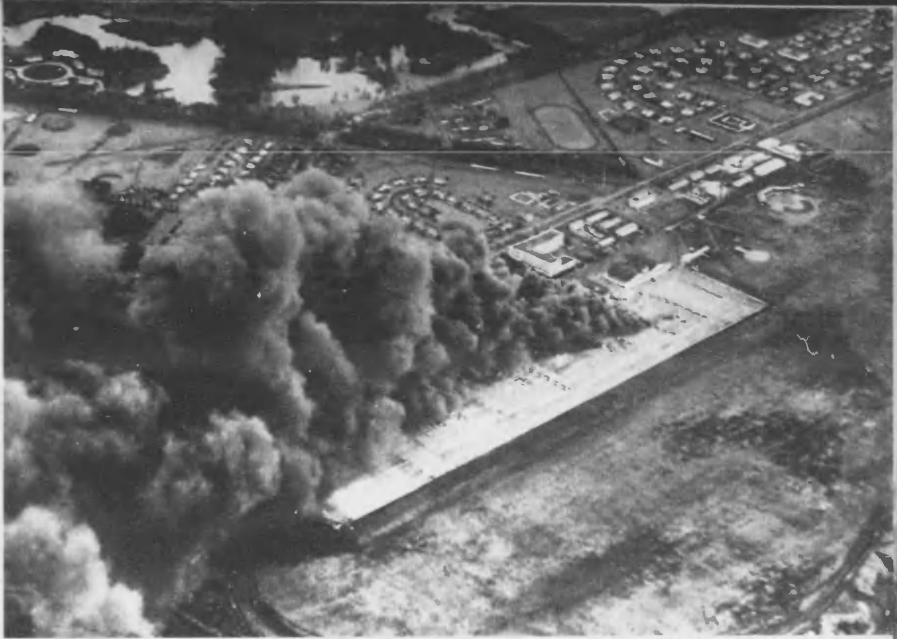
ハワイに陸軍飛行場の爆撃。未だ多数の飛行機が残存してゐるが、これらは第一に空襲の目標として破壊された。また煙にかくれて見えないが、この中には多数の格納庫も燃えており、何れも爆発炎上した。
