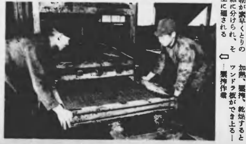
このツンドラ板は断熱、防音、防塵用として非常に効果があることが實踐された。これまで輸入による外に道のなかつたコルク板代用として、ツンドラ板は、時局下に重要な使途をもち、冷蔵庫、冷凍船に、或は建築その他に大いに利用されようとしてゐる。
