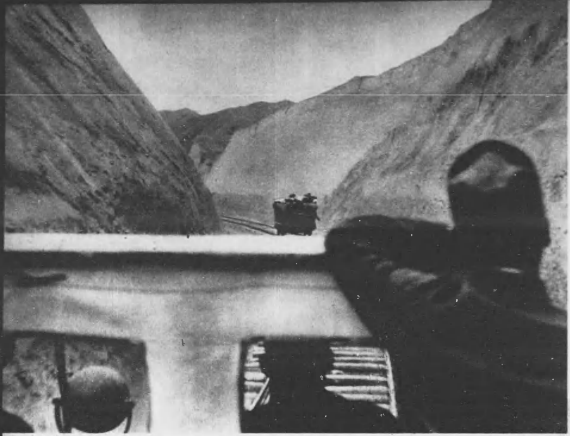
現場連絡に行くモーターカー。見事に切取られた黄土層が見える。事變後新たに建設された包頭、石拐子間を結ぶ大青山線にて。
