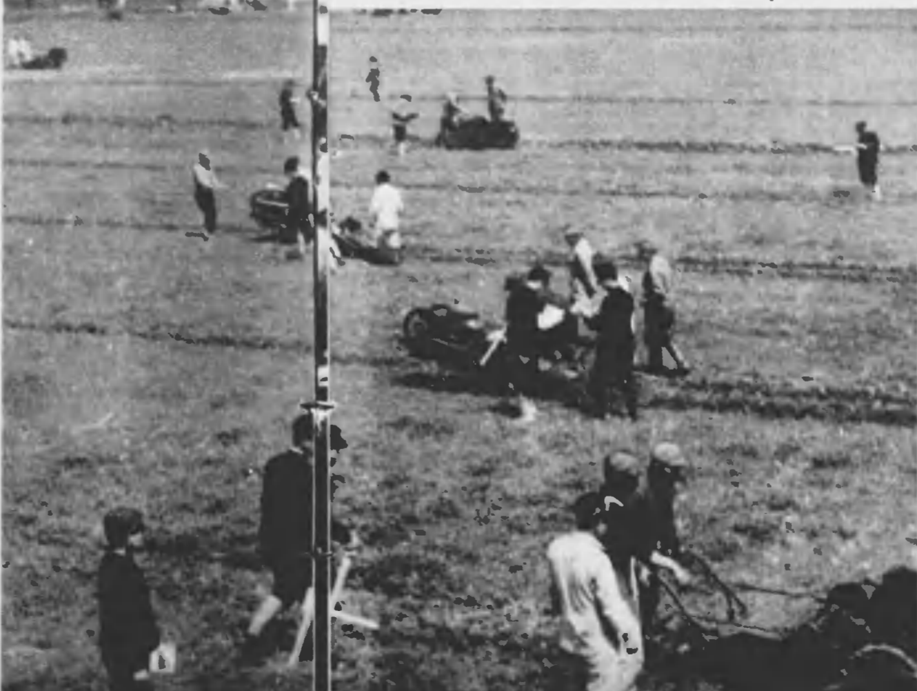
鐵骨の車輛の下から粘土質の土壌は三、四寸の深さに掘りおこされてゆく クラック式、ロータリー式、クランク兼用式の各トラクターがそれ／＼の性能を競演する
