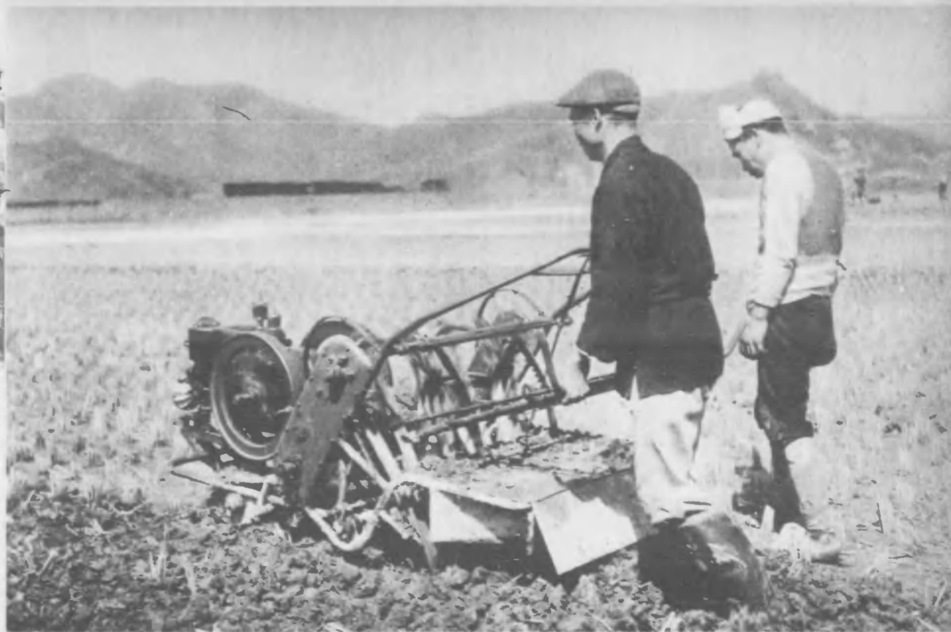
鐵骨の車輛の下から粘土質の土壌は三、四寸の深さに掘りおこされてゆく クラック式、ロータリー式、クランク兼用式の各トラクターがそれ／＼の性能を競演する
