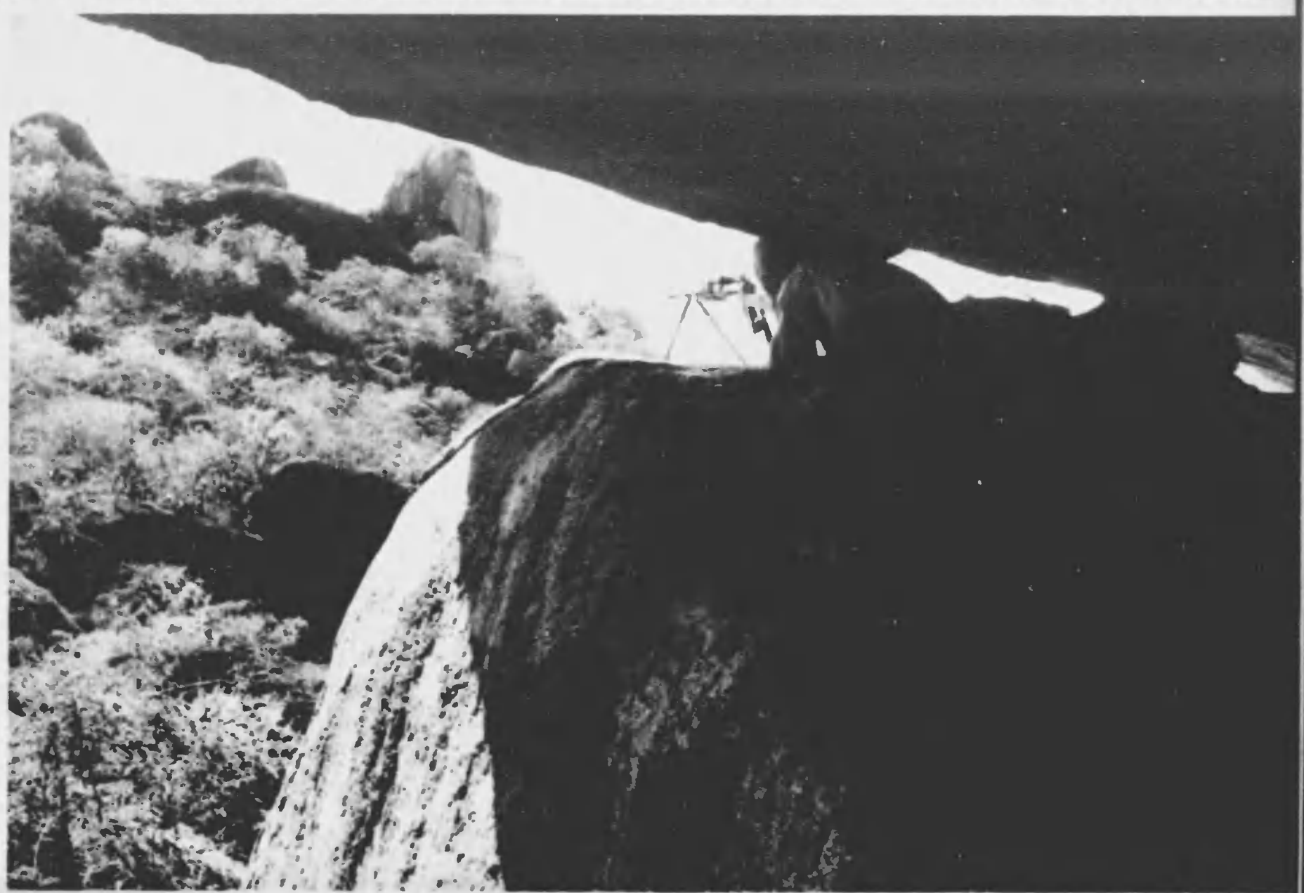
巨岩を利用して構築された機関銃座
