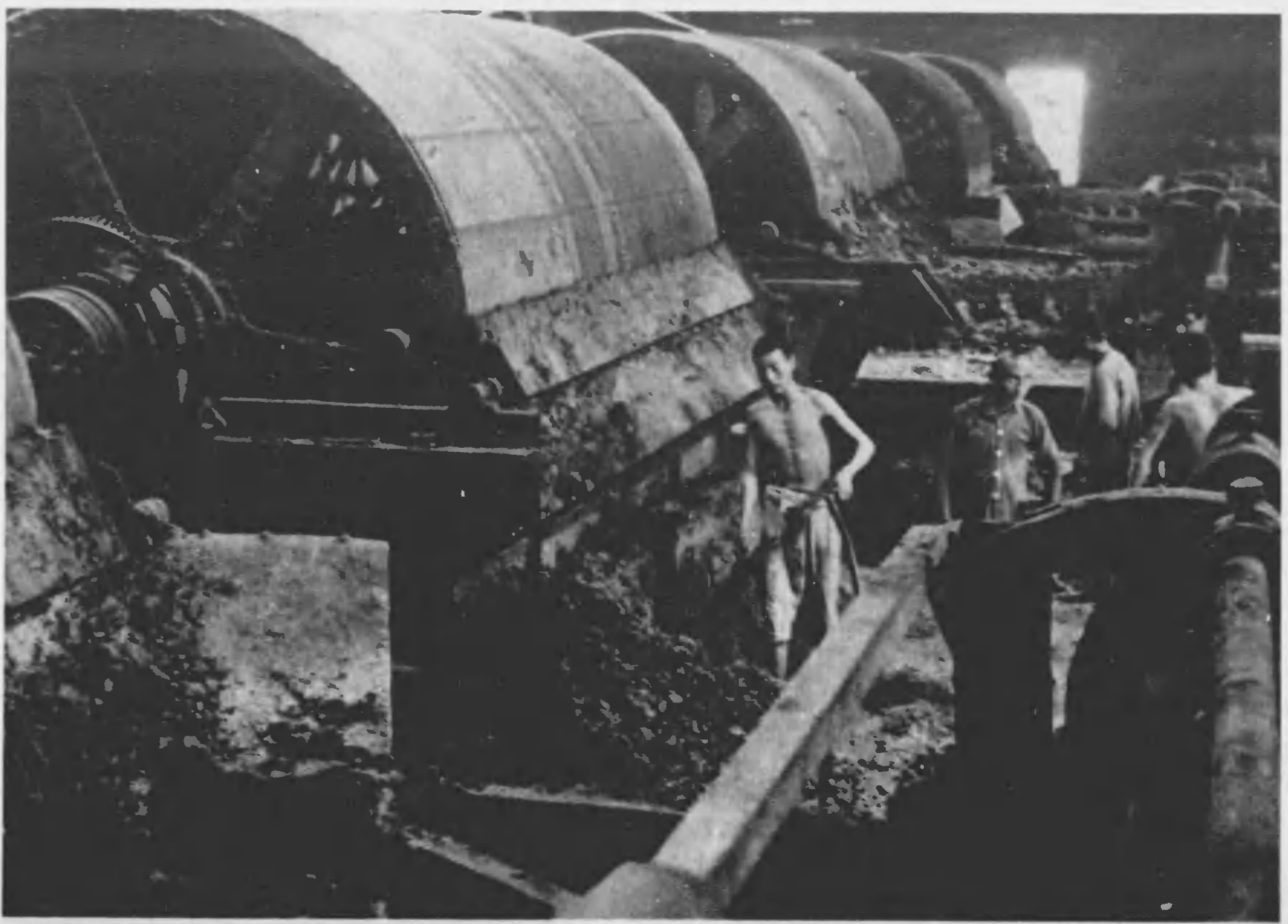
鑛石の浮いた池は脱水機にかけられ、鑛石は乾燥して粉末となる
