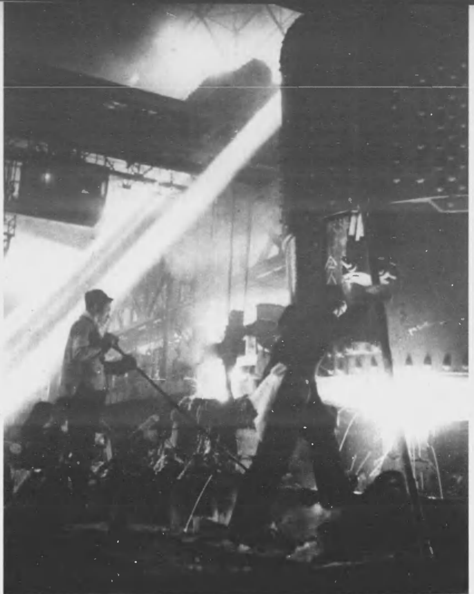
⇐ 熔鑄機にスキップカーで無石 コークス、石灰等を運搬する
