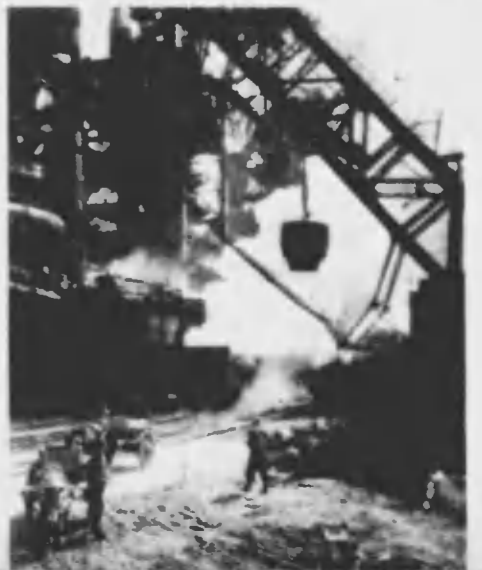
⇐ 熔鑄機にスキップカーで無石 コークス、石灰等を運搬する
