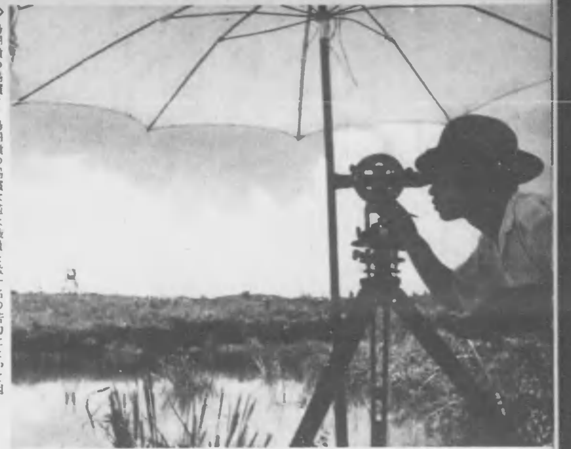
島嶼の測量 島嶼の測量は僅な職員と数十名の苦力によつて困難な測量作業が、ボーリング作業、採掘作業、測量と、どん／＼進められてゐる
