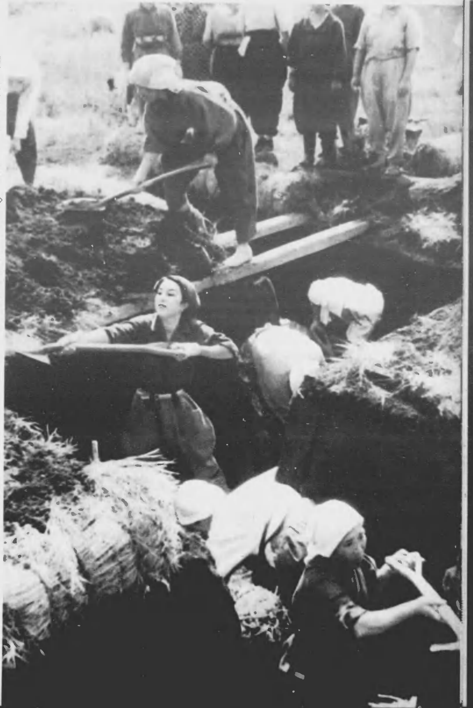
朝九時半の仕事を始め、藤井さんの命令で掘削が始まりました。
