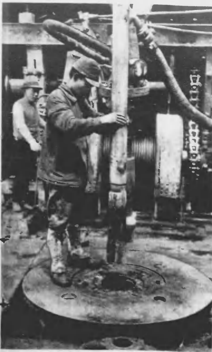
掘削設備 立ち並んだ三四米鐵管内には直徑六インチの掘管がぎつしり詰められてゐる。地下何百尺何千尺と、この掘管を繼いで掘り進める
