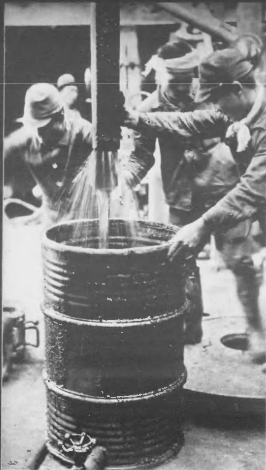
掘削作業 坑内上方から吊下つた掘管身降用の四車フックとフックの作業。左側のホースは掘泥水を循環用のロータリー・ホース。右側のホースは掘泥水をラックで製油場へ運ばれる
