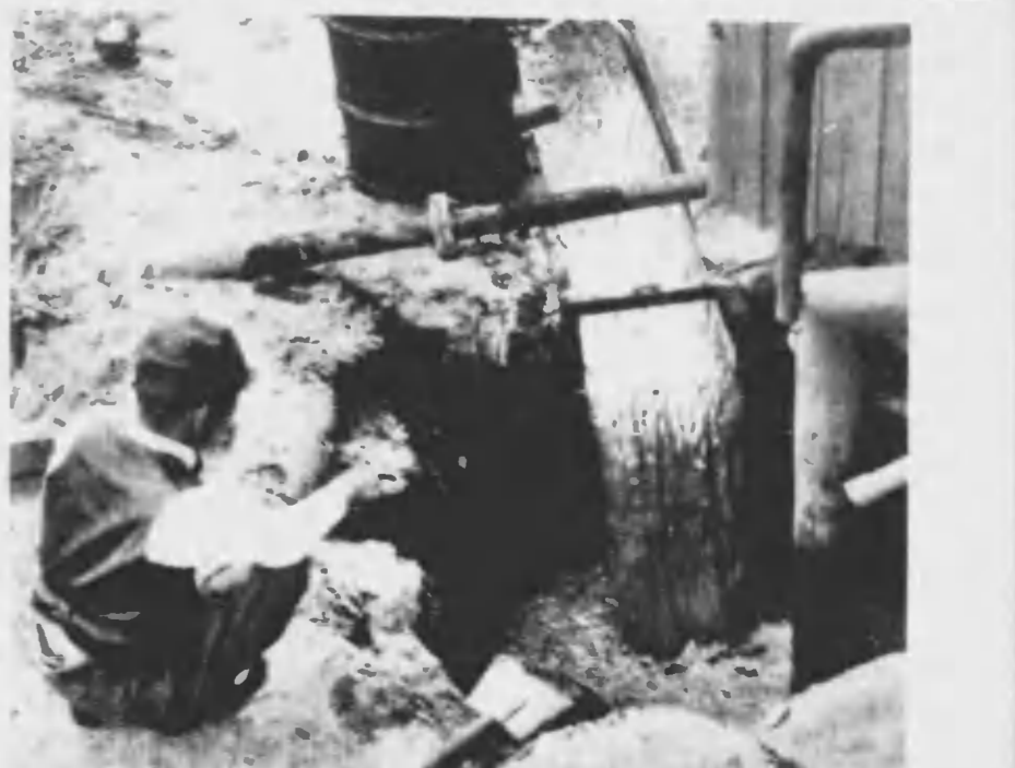
掘削の開始 この地下にはきつと油層があるぞ！四羽ビートを掘管の先端につけて、これから掘削が始まる
