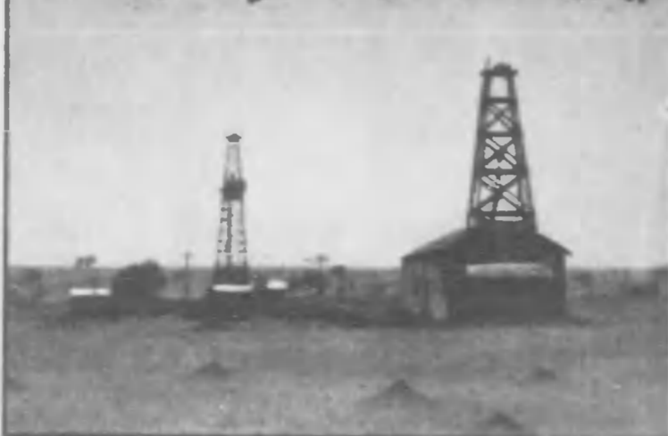
カブトは東岡々營子試掘場の全景。左は「満洲石油あり」の旗歌を上げた殊勲の旗、ロータリー式一號井、右は「式二號井」
