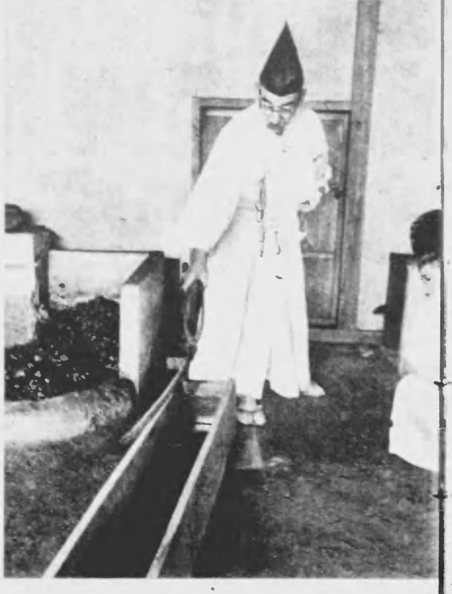
◁ 刀匠の丹精こゝに決する焼入の場。堅傳の湯加減にジユツと定込み次の瞬間白煙があがる。
