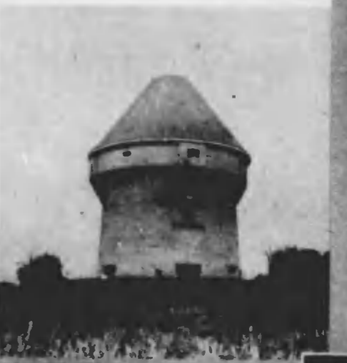
防空要塞線には巧みに迷宮を築いた防空トーチカがあり、防空設備と射撃防備設備を兼ねてゐる
