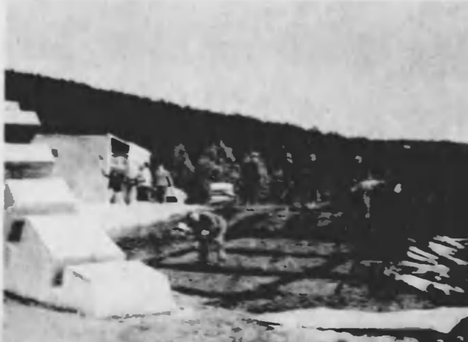
射撃陣壁は鐵筋を組みベトンで固め、ドイツ獨特の筒の曲のやうな形をしてゐる
