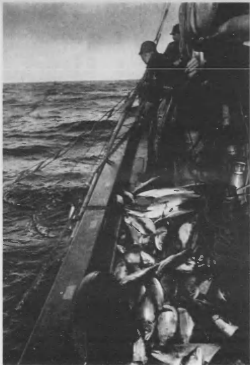
鮭、鱈の沖取は全部流し網で漁獲する。流し網は巾五間、長さは二連から三連位ある。これを川崎船、獨逸船(二十トから五十ト位)に積んで母船から二十連三十連の沖合に運び適當な漁場で真のやうにともら流す。
