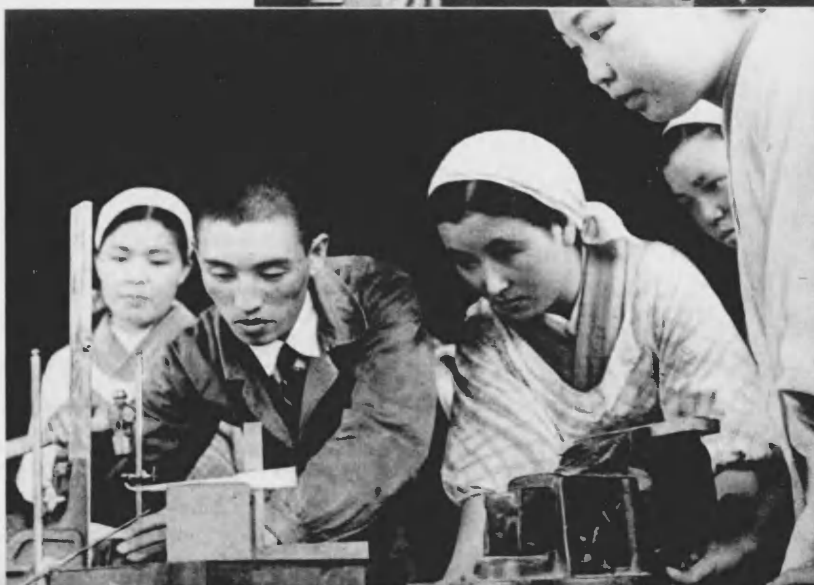
仕上工はヤスリから、細いやさしい指先は仕上げに繊細さがある。開所一ヶ月外徑コンパス使用で平行面の誤差は僅か百分ノ二ミリ程度の上達ぶりである。
