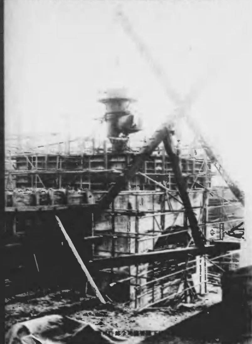
取りつけられたケーソンの中で掘削作業は間断なく進む。試験トンネルの総延長一杆三のうち約四分の三はすでに征服されたのだ
