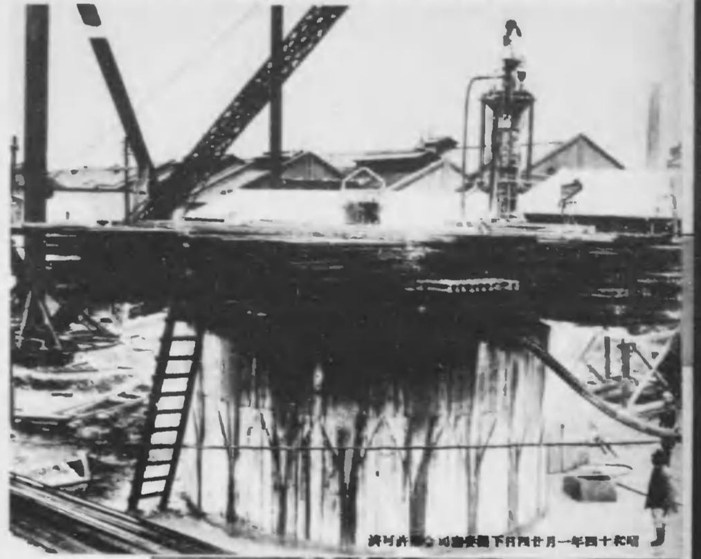
地盤が悪いので大里口豆トンネル整坑に井筒が沈下される。大里口豆トンネル内の試験整坑
