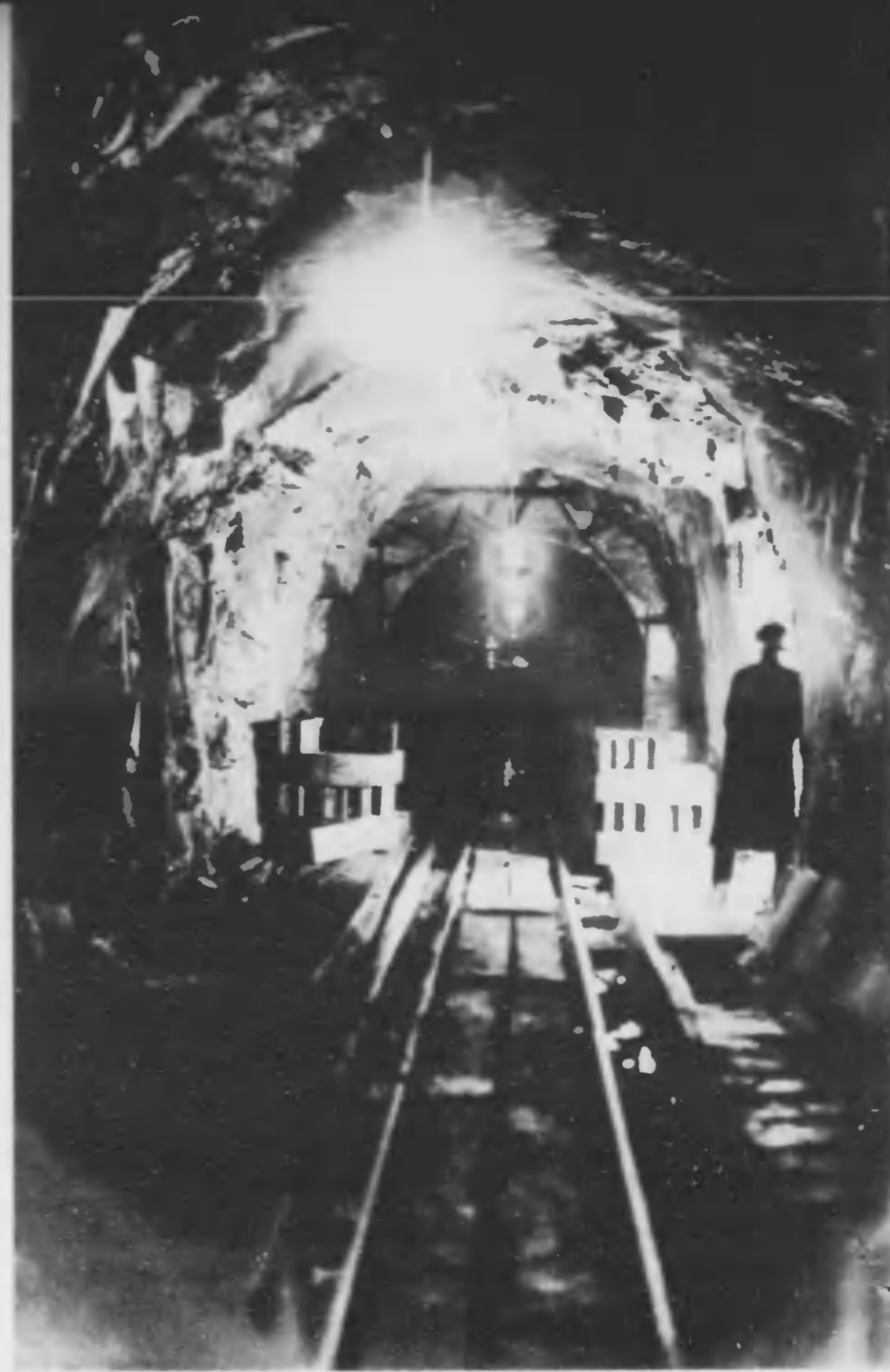
花崗岩の中も豆トンネルは掘鑿されてゆく。標電球が不気味に光る。大里口から四十米奥。試験坑ポンプ室。強力なポンプがトンネルの湧水を地上におしあげ排水する
