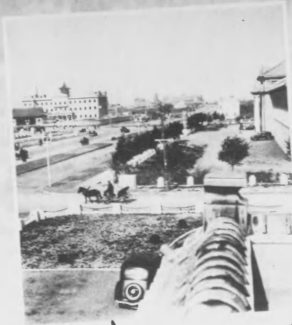
↑ 新京は都市計畫も府々と進み日に月にもさし進歩を遂げ、五族協和の大滿洲國都としての外観を呈へつゝある。寫眞はその官廳街。
