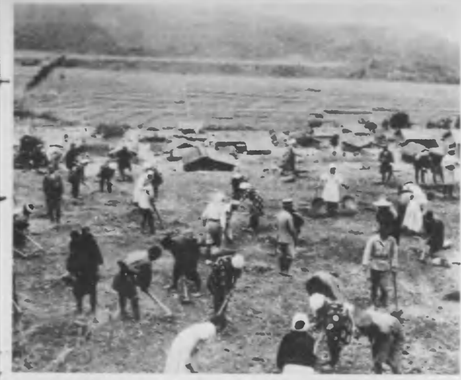
勤勞奉仕は番社の誇り。全島 の舊地に走る垣々たる道路は吟 んどみなこの汗の結晶だ。左は 神社敷地の地均し工事。
