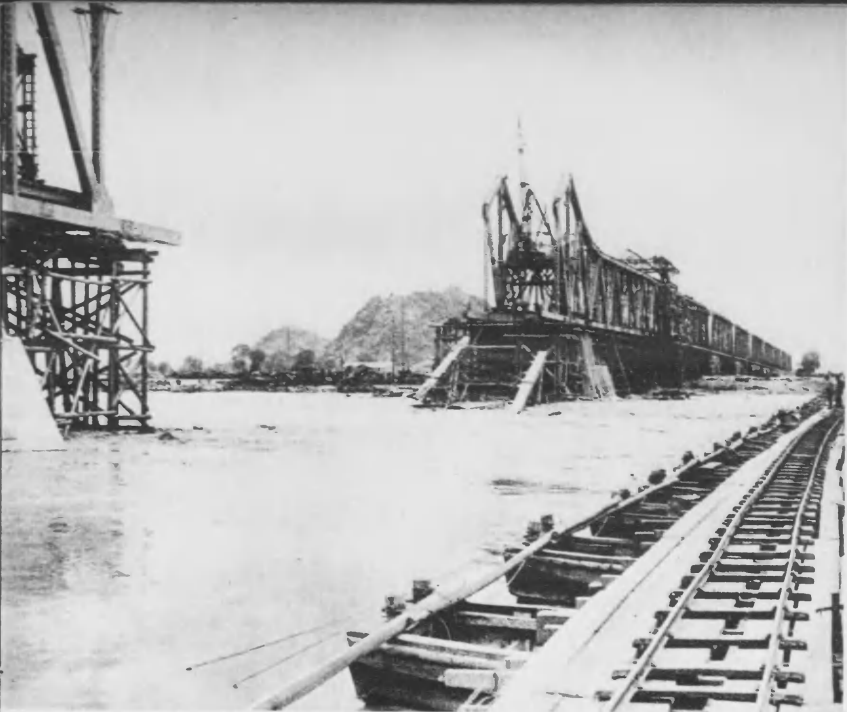
大陸日本建設には凡ゆる困難を克服し て進まねばならない。黄河大橋の修理 は建設戦の第一着手として、本年一月末 工事第一班到着以來、わが土木建築界の 全智全能力をあげて開始された。
