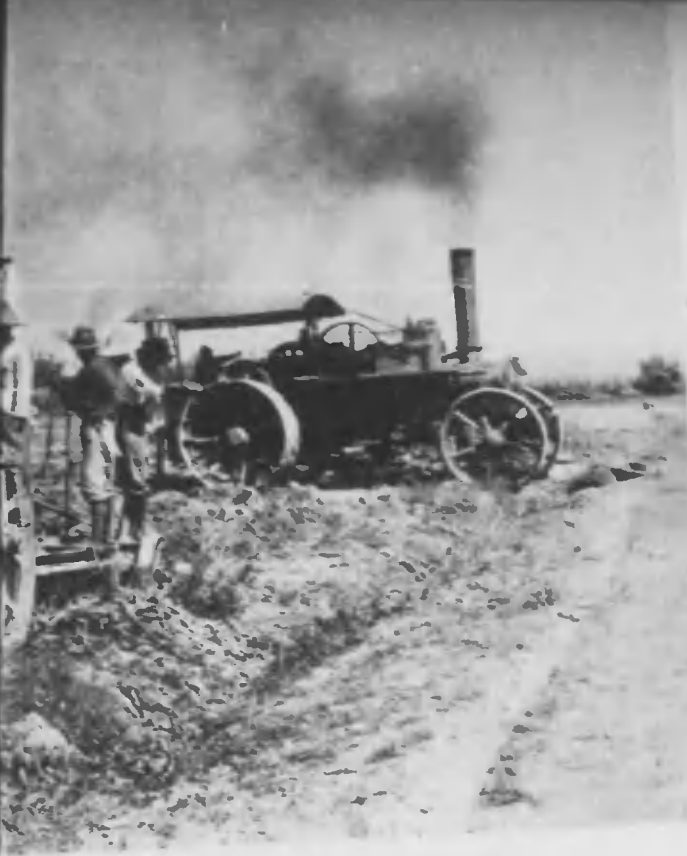
「台湾の砂糖か、砂糖の台 灣か」台湾の製糖業は日本 の自給自足をぐんとひき 上げてゐる重要産業だ。蔗 植付けの耕作も大規模で、 今では牛馬などの動力によ らず、近代科擧を應用した スチームトラウ（蒸氣動力 機）を應用してゐる。
