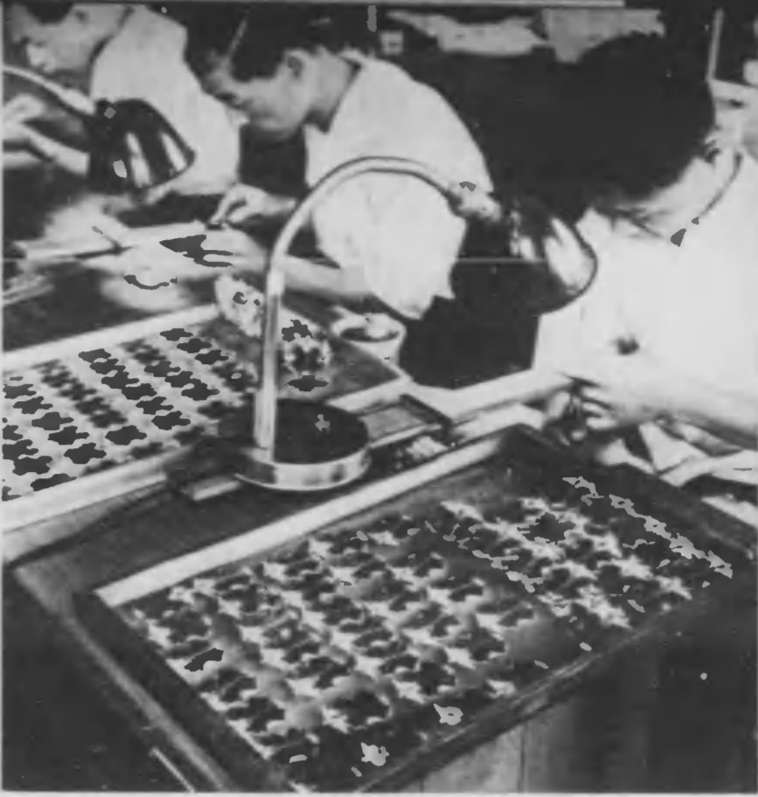
地金は打抜機で打抜かれどく荒い動京の型が出る。そして餘分の端は小さい糸鋸や鑿でけり落されたり修正されたりする。
