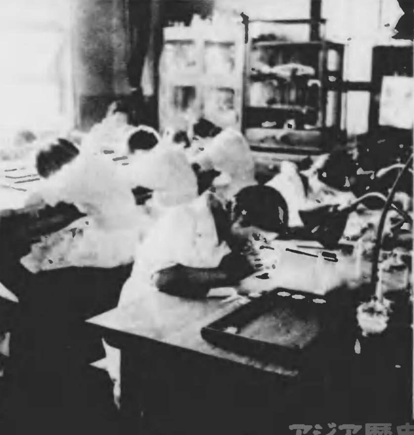
第一段の研磨がすむと、息をこらして女工さんの機手が丹念に七寶のうはくすりを磨りかける。精密な作業だ。
