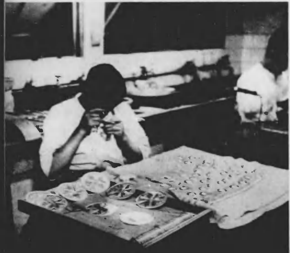
型押しされたレリーフ(浮彫)は上下左右どこも差がないかを確かめる。
