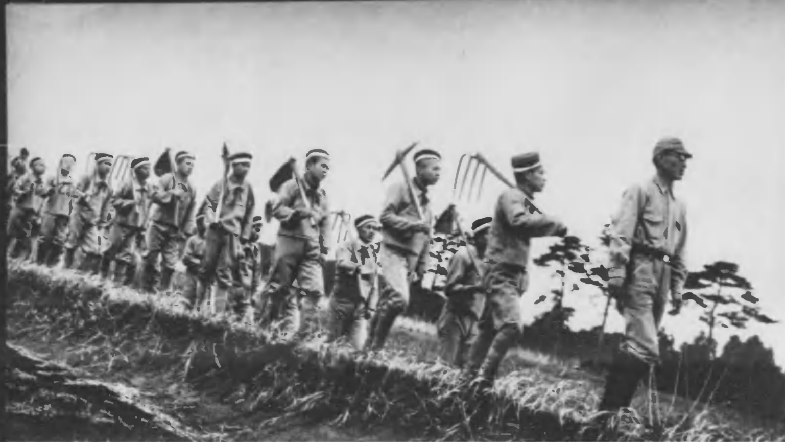
「鉄道の修繕を固めよ」かれらは村の産業道路の修繕を受け、朝早くも村はづれの泥濘克服に向つて奮進する。 千葉・星野学校
