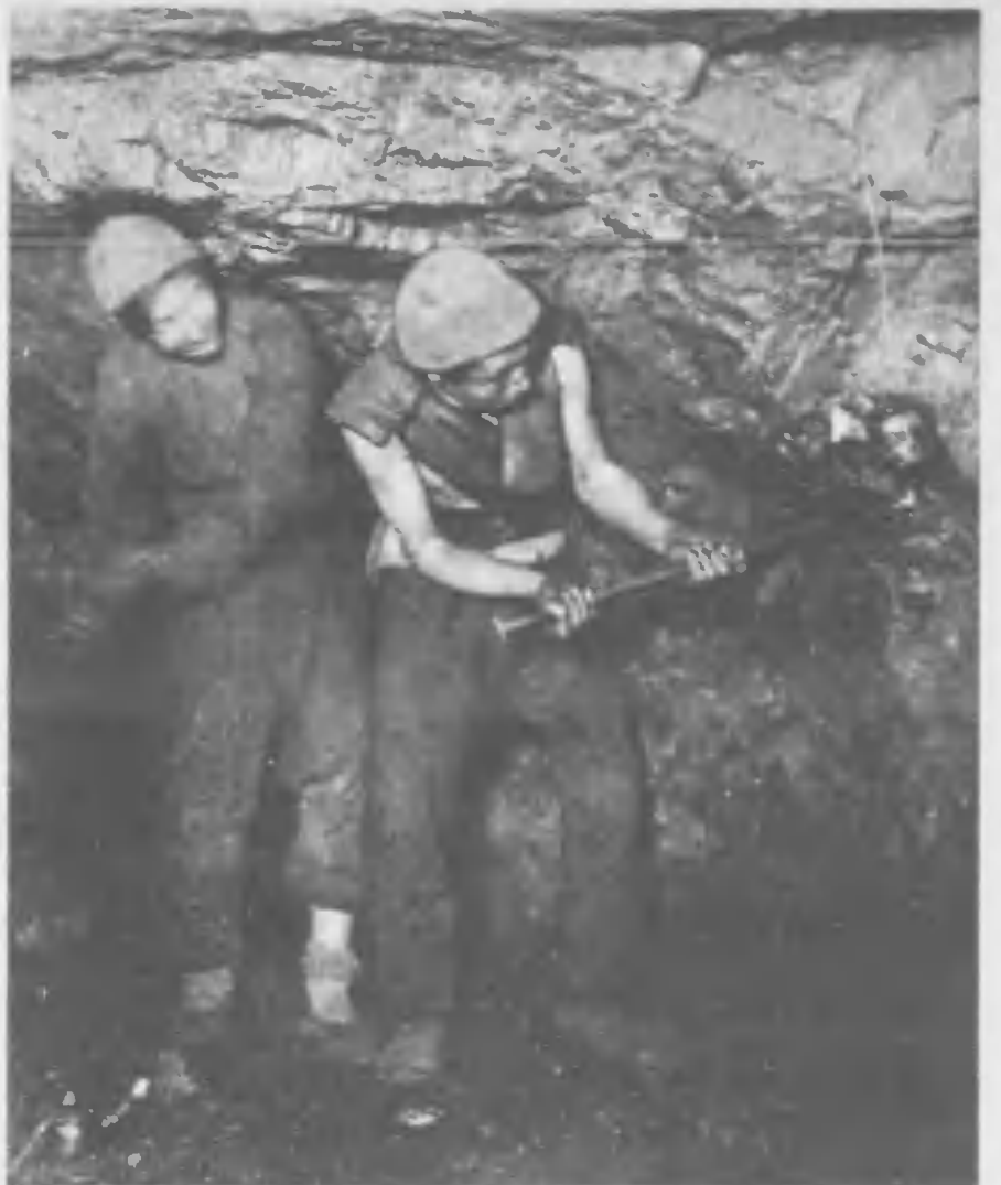
坑木も使はず二人コンビとなつて掘る 水定坑内の作業 炭質もよく、無燧硫の石炭はどん／＼掘 られ、貯炭場は総て山をなす
